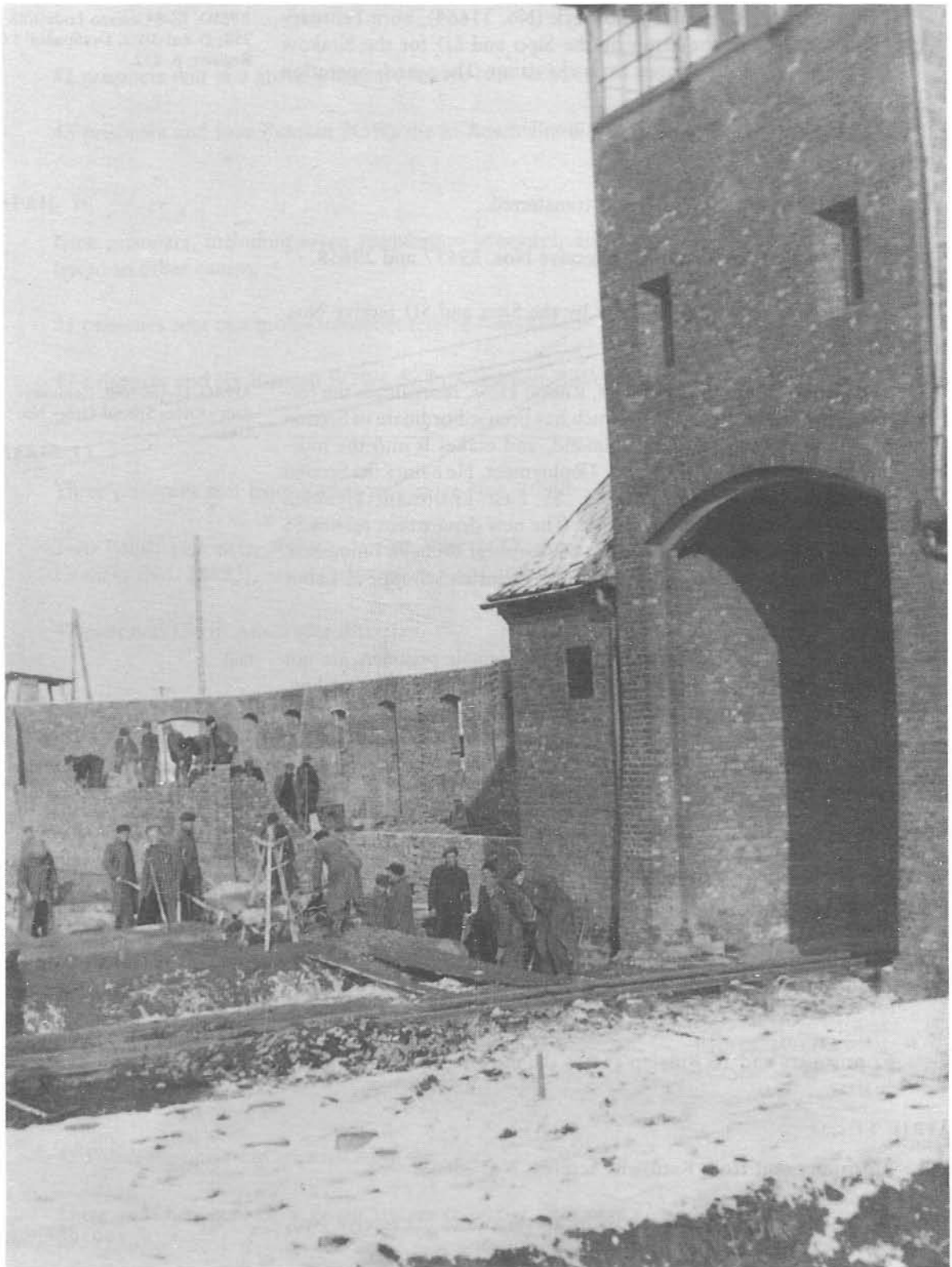
The Trafo (Transformatorstation diente zur Regelung des Eisenbahnverkehrs auf dem Nebengleis—switching station for regulating the sidetracking of railroad traffic) in Birkenau under construction.
