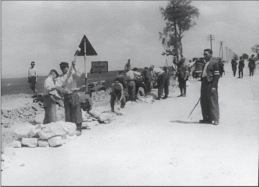
Fig. 13: A Construction Site at the Rollbahn Süd (1942) Photograph: Eliyahu Yones, Die Straße nach Lemberg
