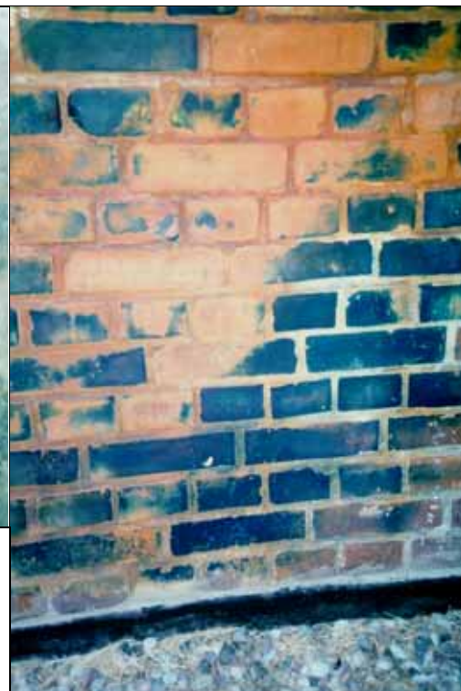
Rechts: Entlausungskammer in Stutthof, Ostseite, außen. Auf den Ziegeln sieht man die typische Blaufärbung der Eisenzyanide.
