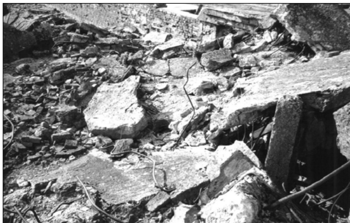
Fotografie 6: Runde Öffnung für das Rohr der Entlüftung auf der Eisenbetondecke des Leichenkeller 2 im Krematorium II von Birkenau. August 2000. © Carlo Mattogno.
