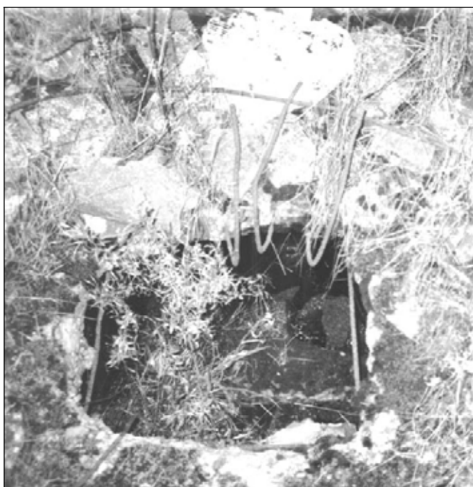
Fotografie 22: Eisenbetondecke des Leichenkeller 1 des Krematorium II von Birkenau. Öffnung Nr. 7 im Oktober 1991.
