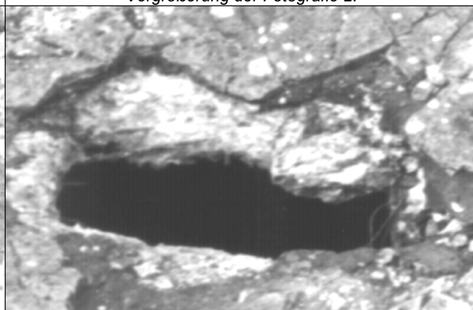
Fotografie 18: Eisenbetondecke des Leichenkeller 1 des Krematorium II von Birkenau. Öffnung Nr. 2 im August 2000.
