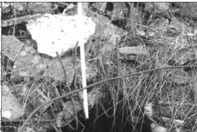
Fotografie 21: Eisenbetondecke des Leichenkeller 1 des Krematorium II von Birkenau. Bewehrungsseisen der Öffnung Nr. 7 im Juni 1990.
