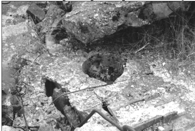
Fotografie 8: Runde Öffnung für das Rohr der Entlüftung auf der Eisenbetondecke des Leichenkeller 2 im Krematorium II von Birkenau. Oktober 1991. © Carlo Mattogno
