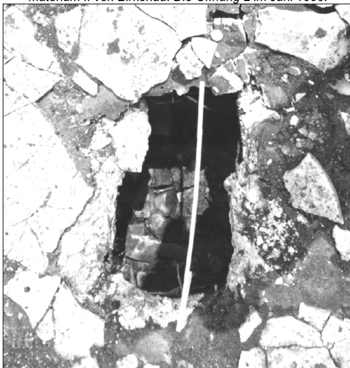
Fotografie 15: Eisenbetondecke des Leichenkeller 1 des Krematorium II von Birkenau. Öffnung Nr. 2 im August 1997. Fotos 13-15, 17, 19: © Carlo Mattogno
