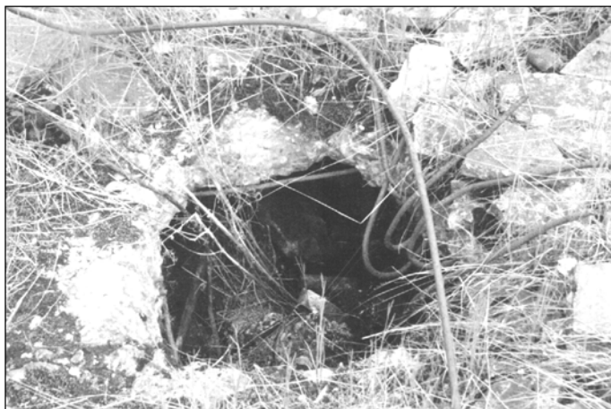
Fotografie 20: Eisenbetondecke des Leichenkeller 1 des Krematorium II von Birkenau. Öffnung Nr. 7 im Juni 1990.
