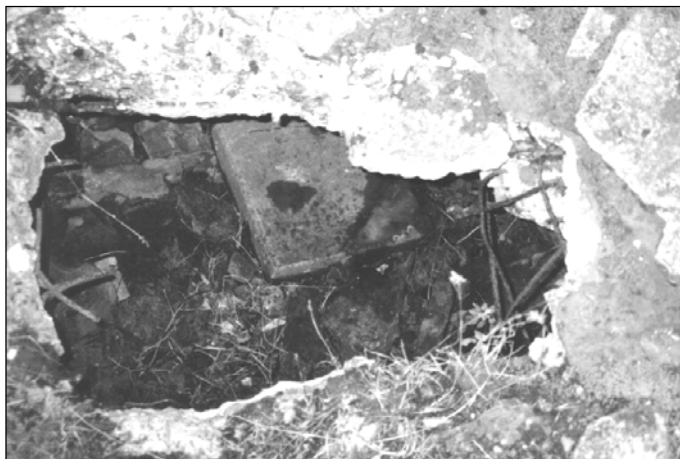
Fotografie 26: Eisenbetondecke des Leichenkeller 1 im Krematorium II von Birkenau. Die Öffnung 7 im Oktober 1991. Innerhalb der Öffnung sieht man den viereckigen Deckel eines Inspektionsschachts der Kanalisation des Krematoriums.
