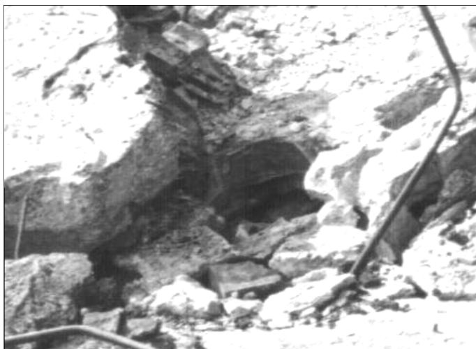
Fotografie 7: Runde Öffnung für das Rohr der Entlüftung auf der Eisenbetondecke des Leichenkeller 2 des Krematorium II von Birkenau. Vergrößerung der Fotografie 6. © Carlo Mattogno
