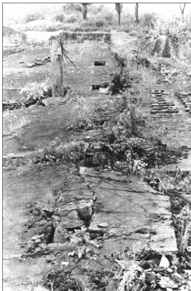
Fotografie 11: Die fünf Ventilationsöffnungen des Dachgeschoßes des Ofenraums im Krematorium III. Fotografie von J.-C. Pressac.
