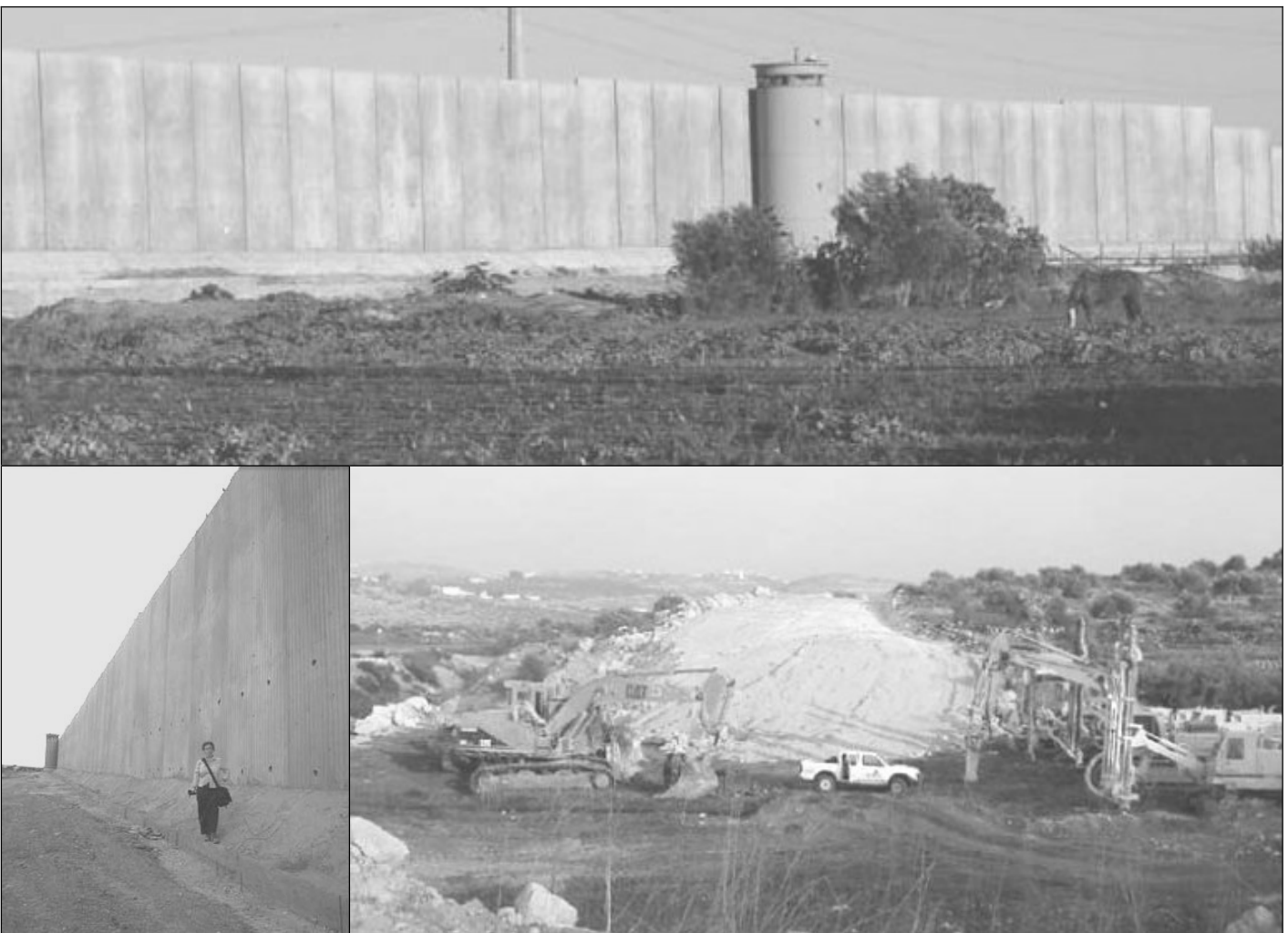
Die Gaza-Mauer, Israels anti-arabischer Schutzwall, im Bau ...
