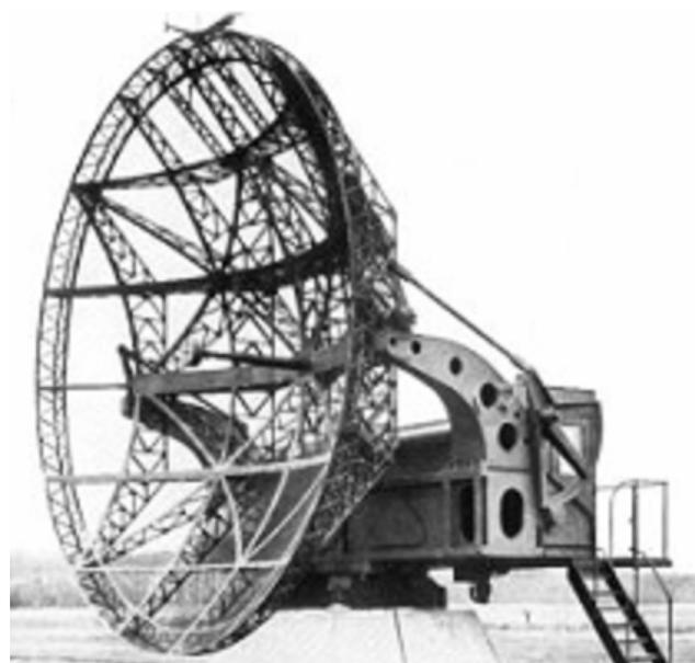
Würzburg-Riese: In der Mitte des Parabols sieht man den rotierenden Dipol.
