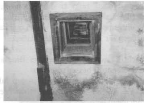
Läuseentwesungskammer in Majdanek mit Blaufärbung und Belüftungsloch in der Decke. 13
